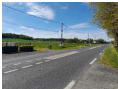
Gestion des tourne-à-gauche par marquage au sol (vue en direction de Loches)
