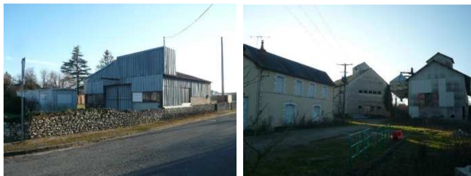
Ancienne entreprise PIOT / Anciens silos près de l'ancienne gare
